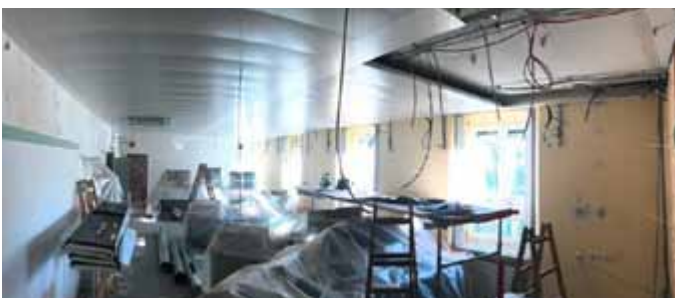
Aktuelle Umbauarbeiten in der LLZ.
